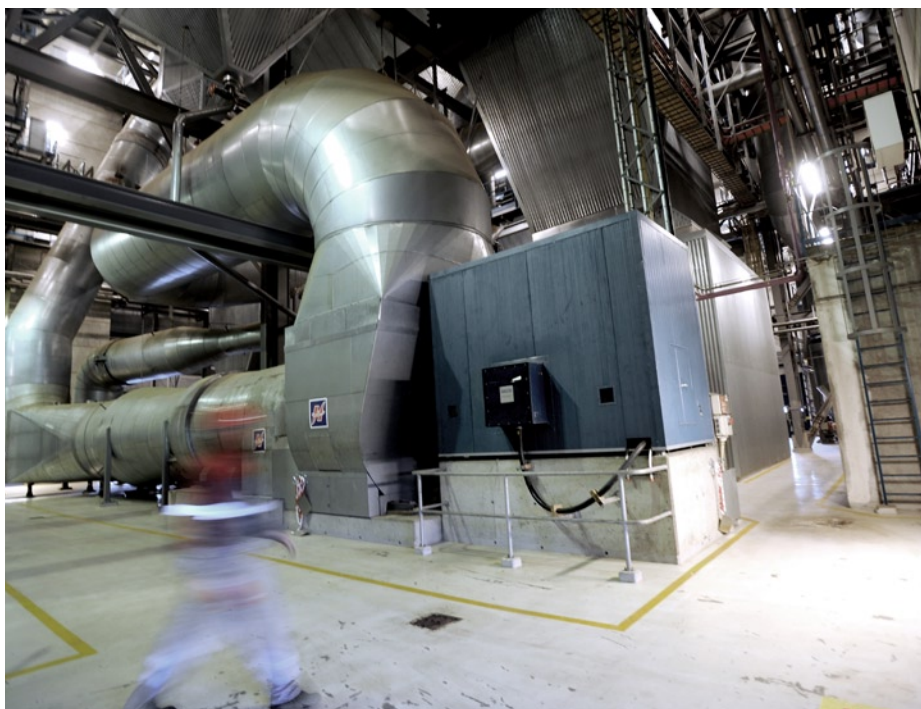
Magnetfelter findes i arbejdsmiljøet både på kraftværker og ved transmissions- og distributionsanlæg. Her er det en stor elmotor på et kraftværk.
